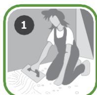
**1** Подготовьте основание пола перед укладкой. Любые неровности основания пола должны быть устранены, чтобы избежать возникновения проблем в дальнейшем. При необходимости соскребите и очистите старый клей перед установкой.
